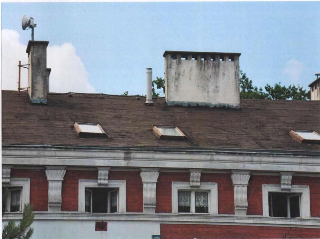
Fot. nr 4. Dach i kominy (elewacja wschodnia).
