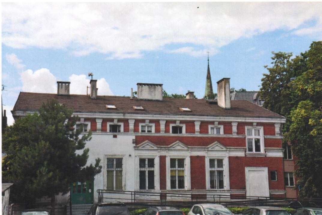
Fot. nr 1. Elewacja wschodnia.
